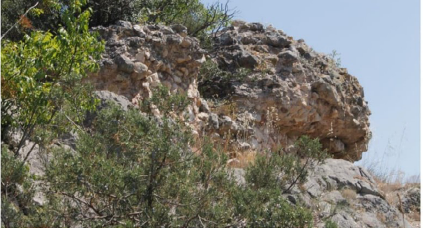
Görsel 2: Çadırılı Hisarı Duvar Detayı
